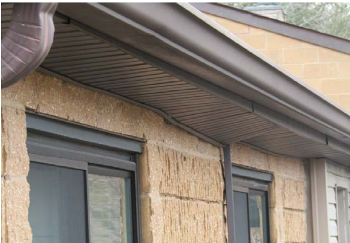
loose soffit
